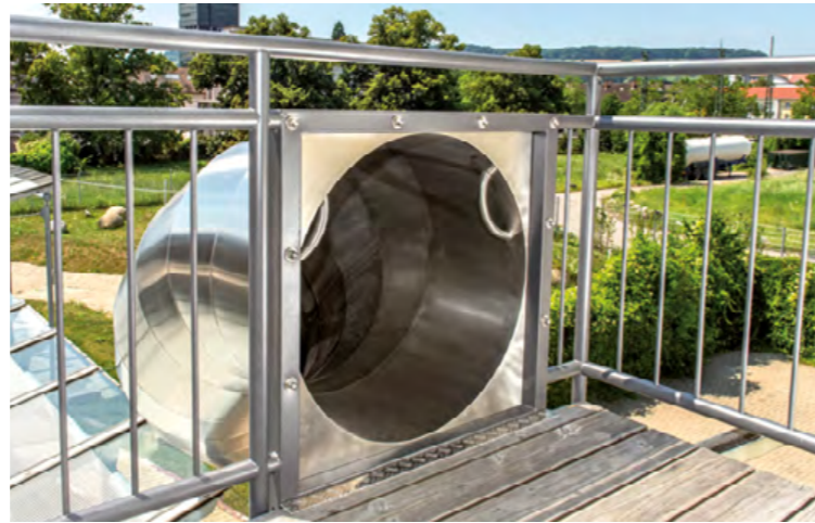
Der Rutscheneinstieg kann gegen unbefugtes Benutzen durch eine Tür mit Fallschloss gesichert werden.
